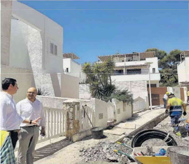
El alcalde de Níjar, José Francisco Garrido, visitó las obras en Agua Amarga. LA VOZ
